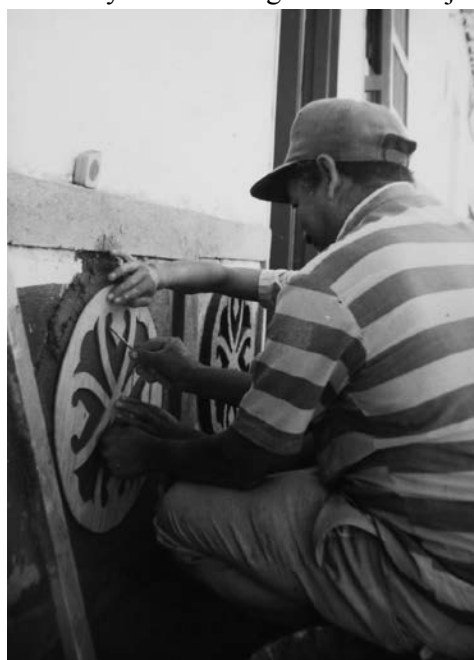
El zocalero Arecio Ríos dando forma al hormigón con sus moldes.
